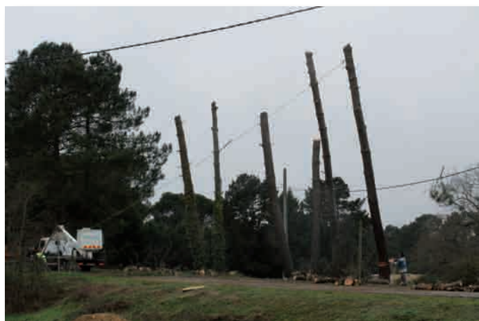
Elagage et abatage des pins réalisés par les agents des services techniques, sur le pont rue du Milan.
